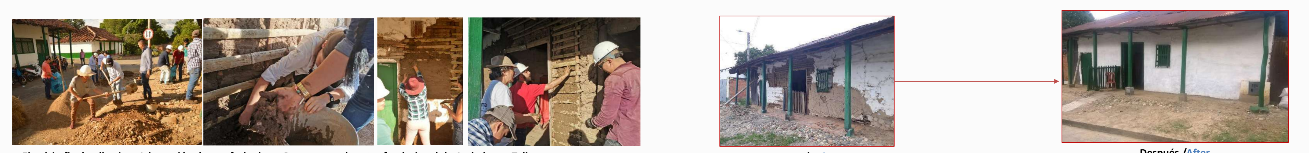
Ejercicio final aplicativo. Adecuación de una fachada en Bareque en el centro fundacional de Ambalema, Tolima. Antes/Before Después /After Final application exercise. Adaptation of a facade in Bareque in the founding Ambalema center, Tolima.
